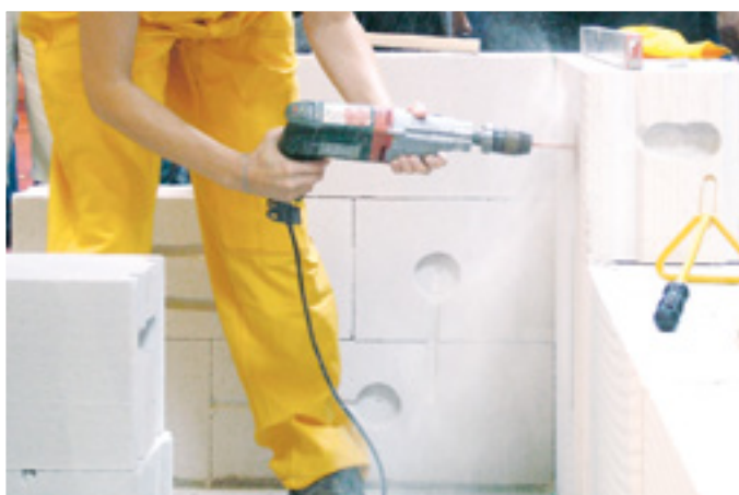
Vrtání do pórobetonu je jednoduché.
