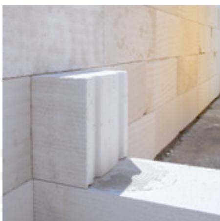
Detail vazby vnitřní a obvodové stěny.
