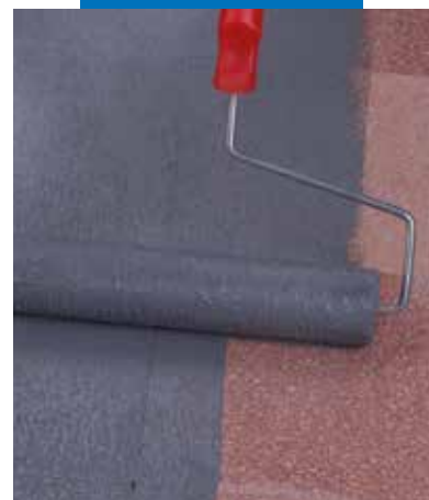
Aplikace Eco Primu Grip válečkem na stávající dlažbu z terazza
