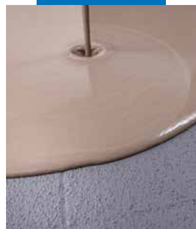
Aplikace samonivelační stěrky Ultraflan na vyschlý Eco Prim Grip aplikovaný na staré podlaze
