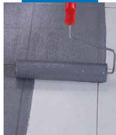
Aplikace Eco Primu Grip válečkem na stávající keramickou dlažbu z gresu
