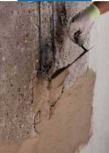
Nanášení směsi Planitop Rasa & Ripara zednickou lžící
