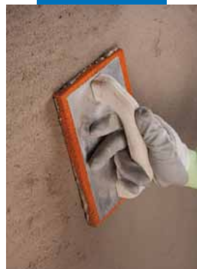
Úprava povrchu Planitop Rasa & Ripara
