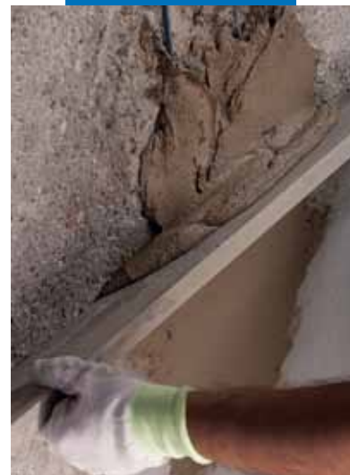
Stahování směsi Planitop Rasa & Ripara hliníkovou latí
