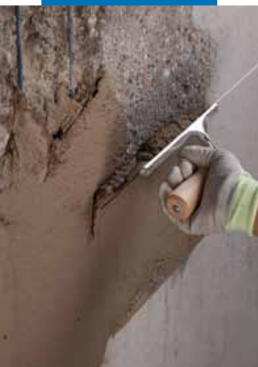
Nanášení směsi Planitop Rasa & Ripara hladítkem
